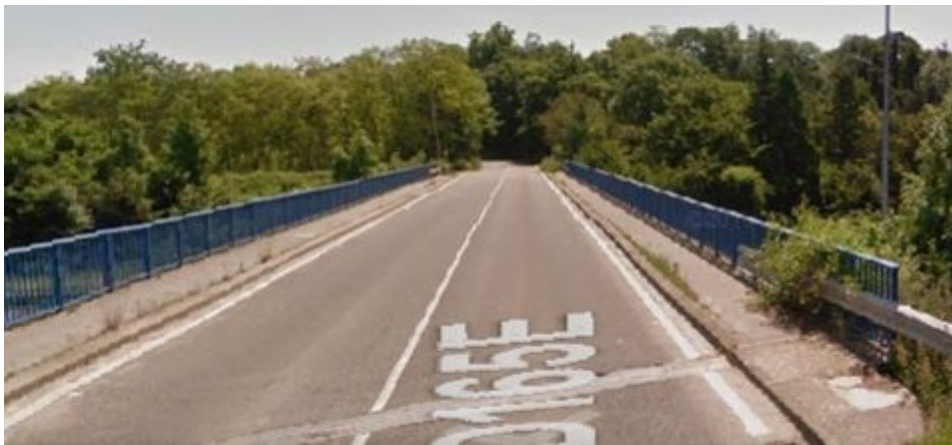
VISUEL N° 1 : Traversée par le pont surplombant l'autoroute (cote 100)
