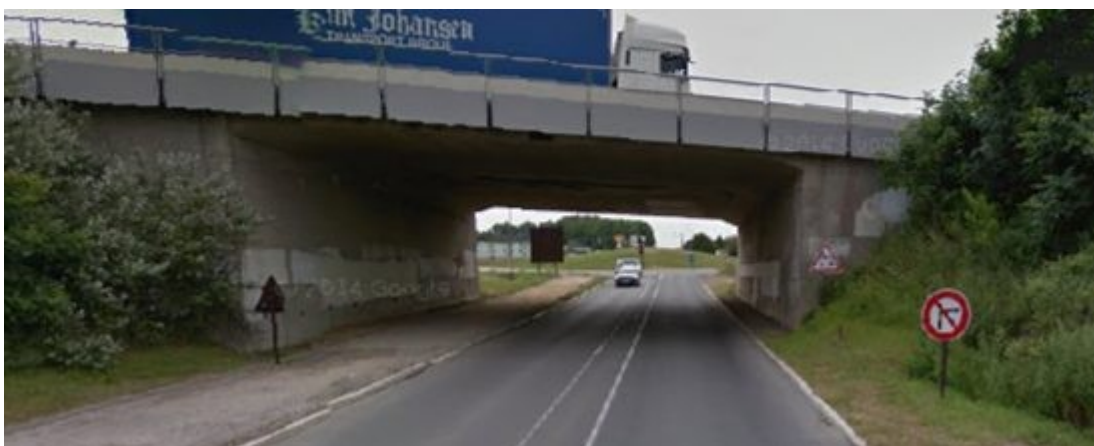
VISUEL N° 3 : Traversée de la RN2 (St Mard)
