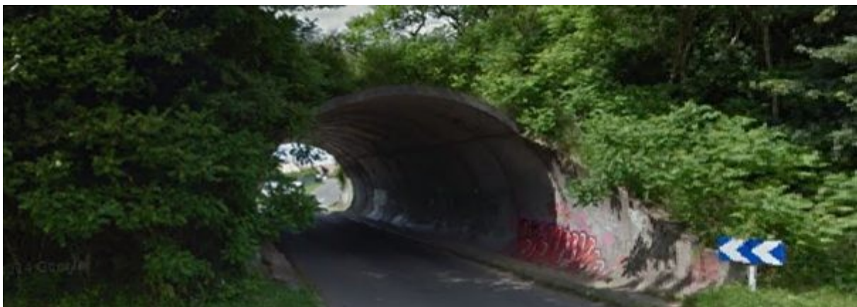
VISUEL N° 2 : Passage sous la RD 9
