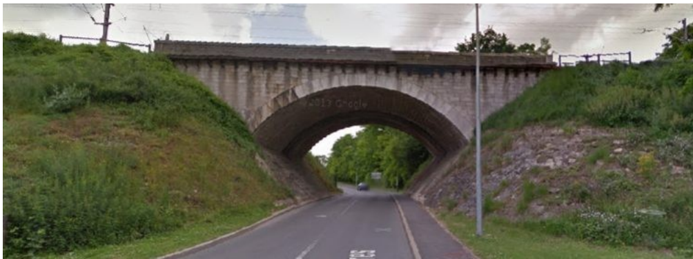
VISUEL N° 1 : Passage sous la voie ferrée, cote 101
